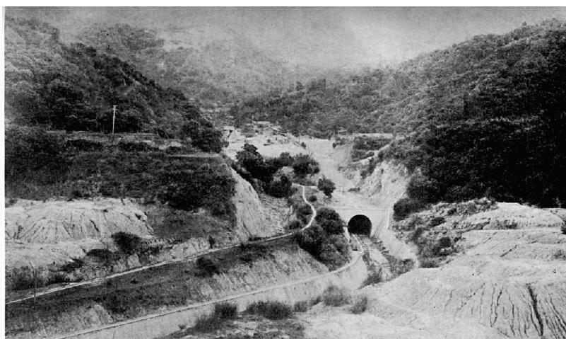
曾文溪的溪水由此進入三公里長的烏山嶺隧道流向烏山頭水庫
