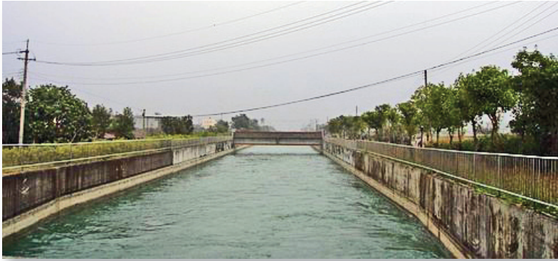
嘉南大圳北向通往嘉義的灌溉水道
